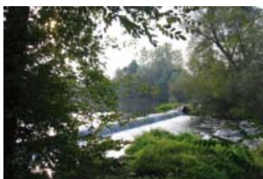
588,7 Próg wodny w Kamionie
