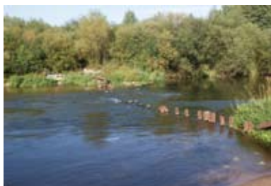
575,0 Zniszczony próg wodny w Kajdasie
