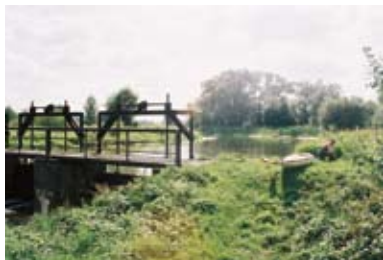
713,2 Jaz w Skrzydlowie
