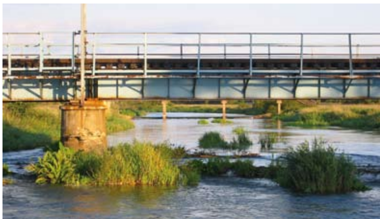
Progi na Warcie koło mostu kolejowego w Bobrach (681,9 km)
