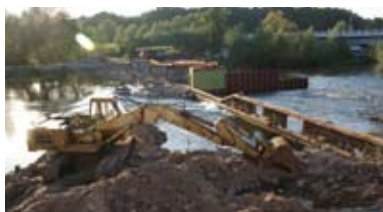
560,1 Budowa elektrowni wodnej w Konopnicy
