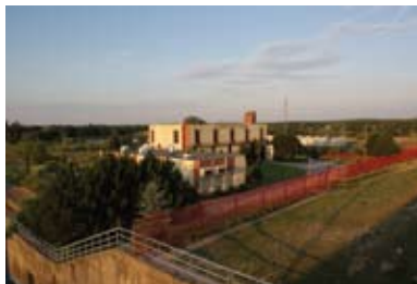
484,3 Elektrownia wodna w Skęczniewie
